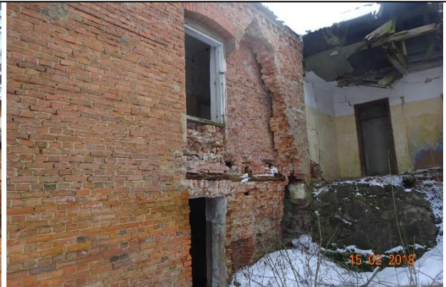
F-8. Ķieģeļu mūris ar izdrupušiem fragmentiem
