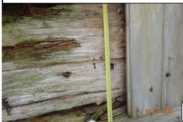
F-24. Koka ārsiena bez hidroizolējoša starpslāņa
