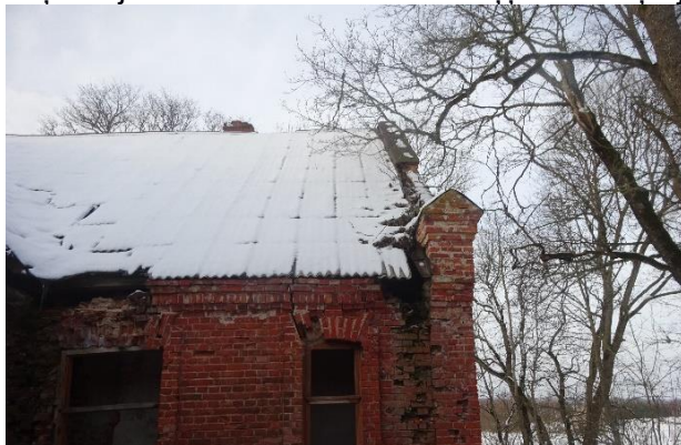
F-34. Azbestcimenta lokšņu jumta segums
