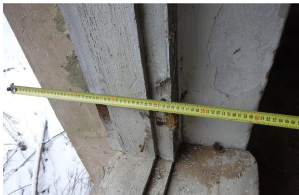
F-15. Ķieģeļu mūra ārsienas biezums ~640mm
