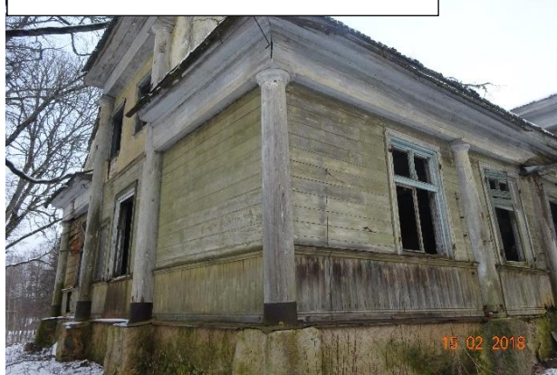
F-18. Koka kolonnas ēkas fasādē
