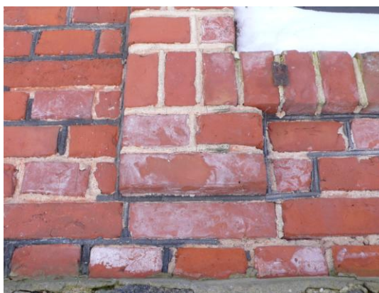
C korpusa fasādes fragments. Sarkani krāsots mūris, baltas un pelēkas šuves. Analogi mūrējumi bijis arī D korpusam.
