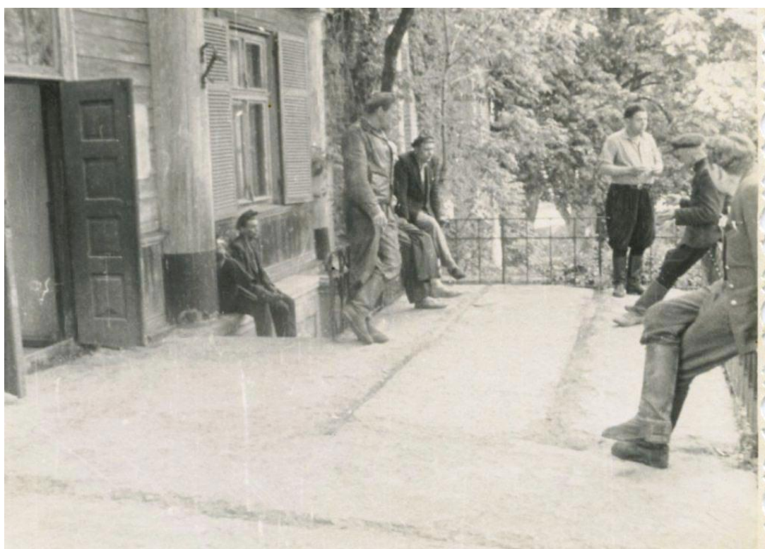
Skats uz terasi ap 1960 gadu. 20. gs. 2. p. durvis ar virslogu, 19. gs. 2. p. logs ar slēģiem un metāla margas. Iespējamais terases flīžu segums zudis, jo redzamas starp pārseguma velvēm liktās sliedes. Oriģināls Sēlijas muzejā Viesītē. Inv.Nr. SeM -pl 1093, 13-15
